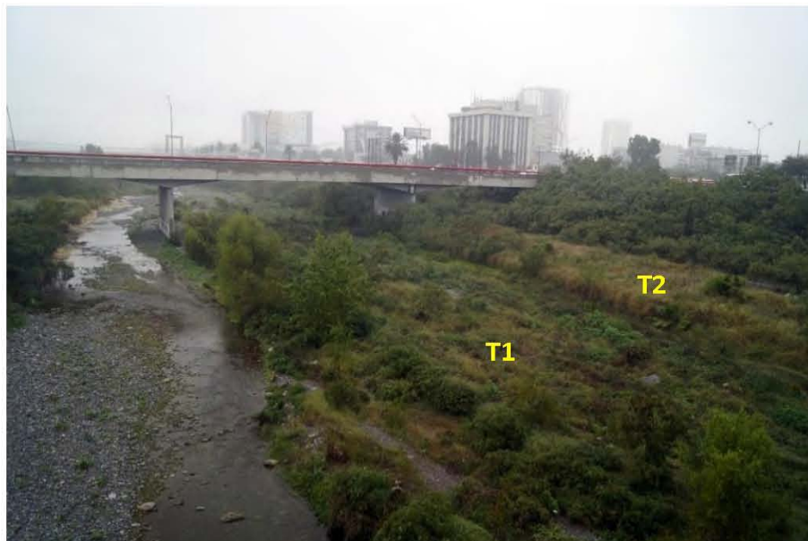
Figura 48. Dos niveles de terrazas (T1 y T2) en la llanura de inundación del río Santa Catarina, entre los puentes de las avenidas Cuauhtémoc y Pino Suárez (diciembre 2017).
