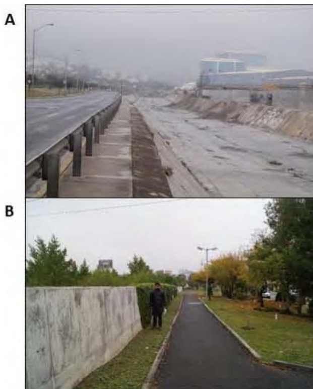
Figura 45. (A: ★) Obras de contención en Río El Obispo, canal amplio y con desazolve para facilitar el paso del torrente fluvial. (B: ★) Barda-dique (de 1.6 m de altura), evita las inundaciones estacionales en la colonia Rincón de la Primavera. Las estrellas muestran la localización de las imágenes en la figura 42 (diciembre, 2017).
