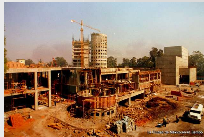
Construcción CNA, Tlalpan; Fuente: almomento.com.mx
