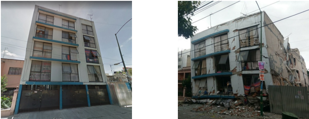
Fig. 3.6 Antes y después de un edificio de cinco niveles con PBD ubicado en Saratoga 74, Portales Sur, Ciudad de México. Fuente https://www.huffingtonpost.com.mx/2017/09/23/fotos-el-antes-y-despues-de-los-edificios-derrumbados-en-cdmx_a_23220020/
