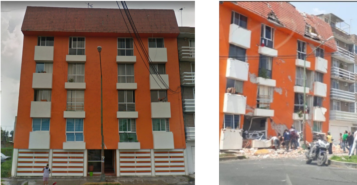
Fig. 3.1 Antes y después de un edificio de cinco niveles con PBD ubicado en Paseo de las Galias 47, Colonia Lomas Estrella 2da Secc, Ciudad de México. Fuente https://www.huffingtonpost.com.mx/2017/09/23/fotos-el-antes-y-despues-de-los-edificios-derrumbados-en-cdmx_a_23220020/
