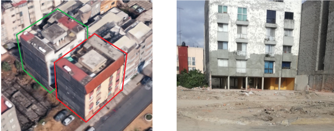
Fig. 4.2 Edificio gemelo observado en la visita de campo
