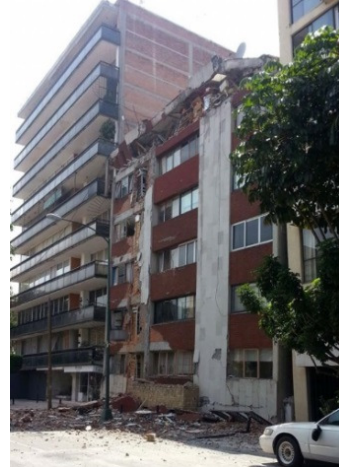
Fig. 3.2 Antes y después de un edificio de seis niveles con PBD ubicado en Patricio Sanz 37, Colonia del Valle Norte, Ciudad de México. Fuente https://www.huffingtonpost.com.mx/2017/09/23/fotos-el-antes-y-despues-de-los-edificios-derrumbados-en-cdmx_a_23220020/
