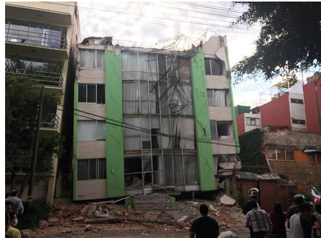
Fig. 3.3 Antes y después de un edificio de cinco niveles con PBD ubicado en Enrique Rébsamen 241, Narvarte Poniente, Ciudad de México. Fuente https://www.huffingtonpost.com.mx/2017/09/23/fotos-el-antes-y-despues-de-los-edificios-derrumbados-en-cdmx_a_23220020/
