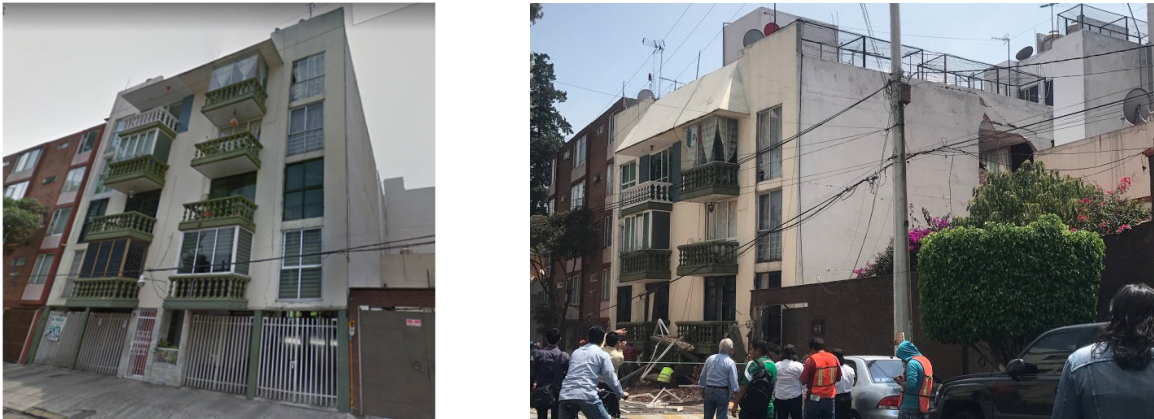
Fig. 3.5 Antes y después de un edificio de cinco niveles con PBD ubicado en Balsas 18, Miravalle, Ciudad de México. Fuente https://www.univision.com/noticias/terremotos/estos-son-los-edificios-que-colapsaron-con-el-terremoto-en-mexico-antes-y-despues
