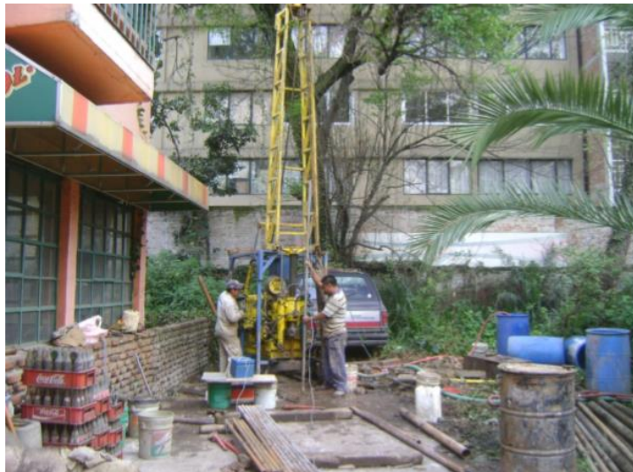
Figura 4. Ejecución de Sondeo de Cono Eléctrico, SCE 1.
