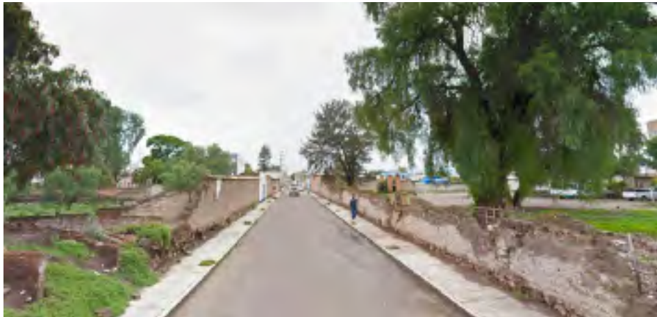
Vista 1. Lado este del predio, Calle 16 de septiembre. Fuente: Google Maps
