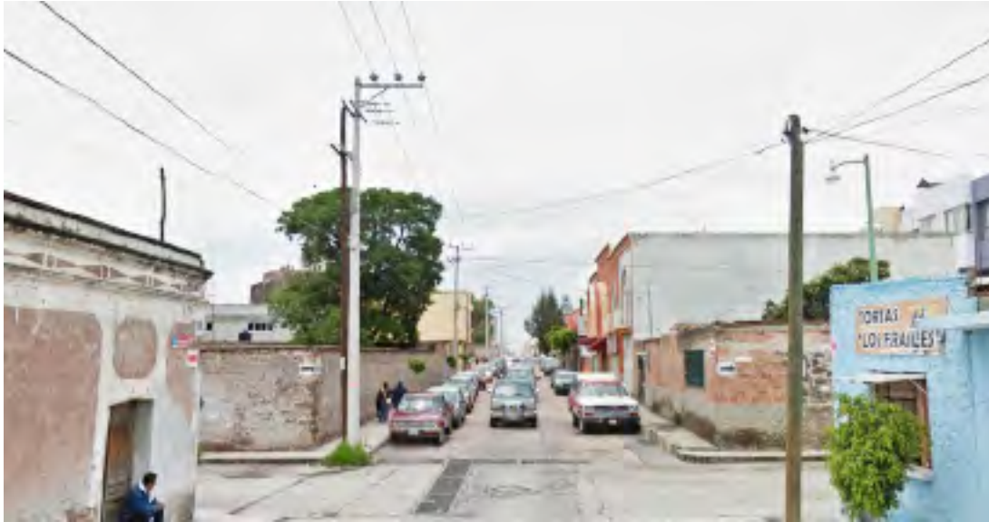
Vista 4. Calle Hidalgo al norte del predio, infraestructura visible. (Drenaje, electricidad, vialidades, etc.) Fuente: Google Maps
