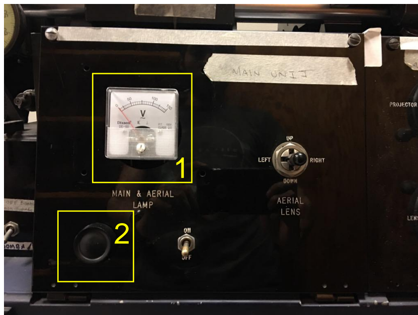
Imagen 20. Adaptación de los elementos a la consola. 1) Voltímetro de aguja 2) Dimmer.
