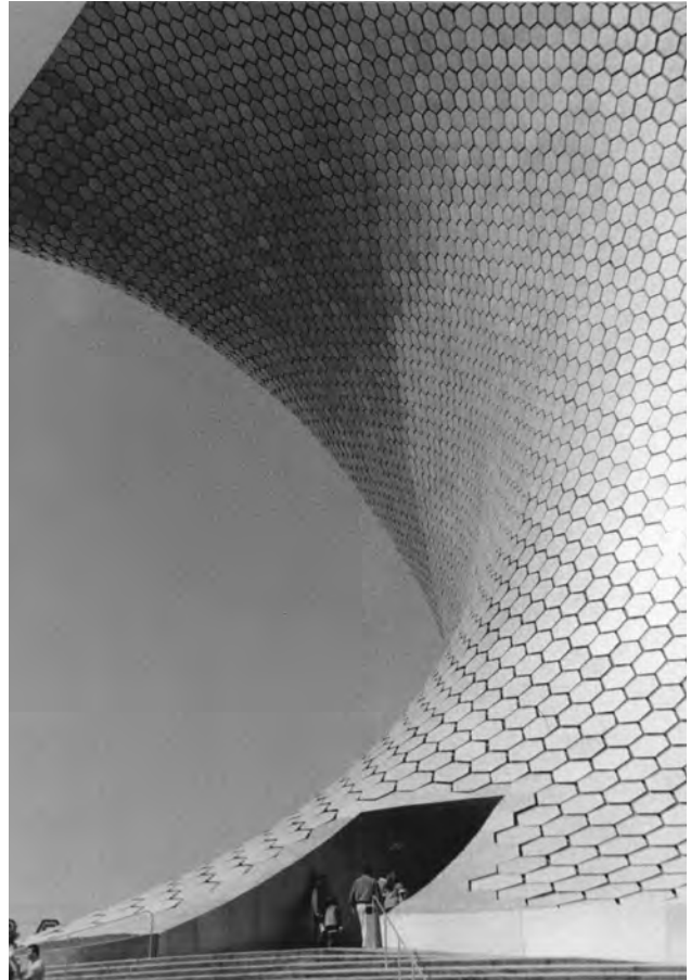
II.20. La unión de los elementos permiten generar una composición de interés
