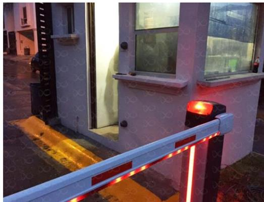
*Figura 5. Incorporación de la electrónica en la pluma*
