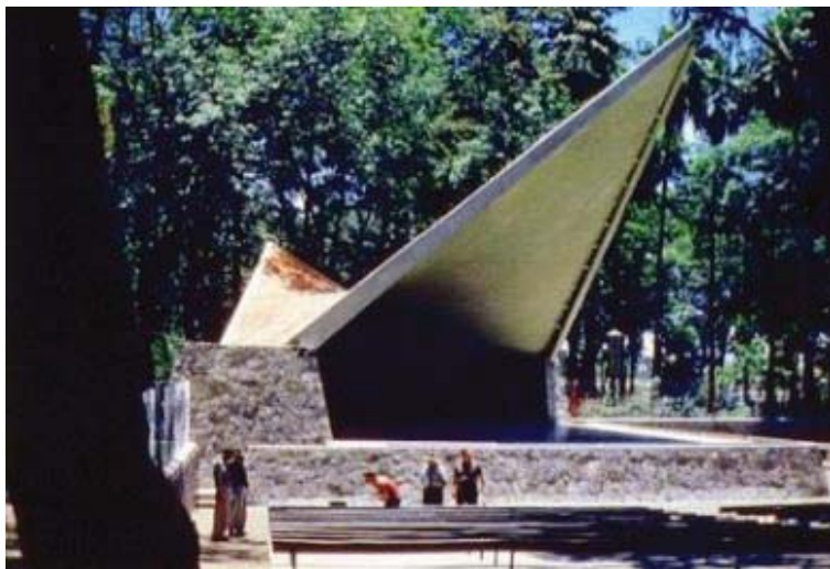
Imagen 24. Cubierta del escenario del foro del parque de Agua Azul. Fuente: Pagina web Informador.mx http://www.informador.com.mx/cultura/2013/461876/6/concha-acustica-sinonimo-de-la-historia-cultural-tapatia.htm (última vez revisada: 17/07/2018).
