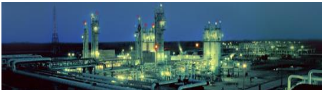
Figura 5.4 Complejo Procesador de Gas, (PEMEX, GAS)
