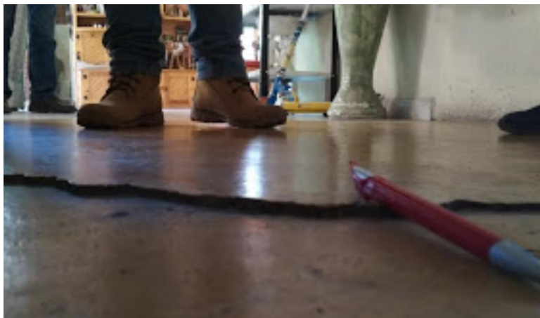
Fotografía 34. Fractura en el pasillo de la sala a la cocina.
