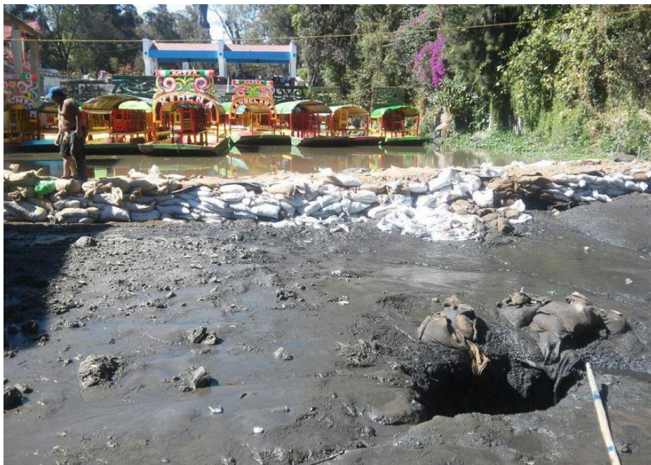
Figura 28. Hundimiento en el canal, cerca del embarcadero Zacapa-Nativitas. Tomada de: Noticieros Televisa
