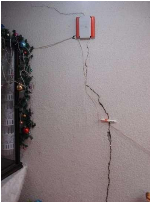
Fotografía 4. Fractura en la pared de las escaleras.
