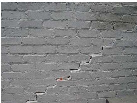
Fotografía 23. Fracturas en la pared.
