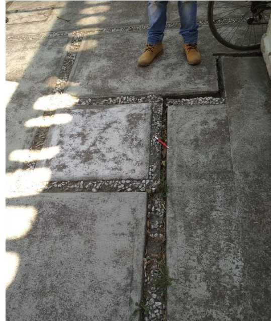
Fotografía 35. Apertura de lozas en patio delantero.
