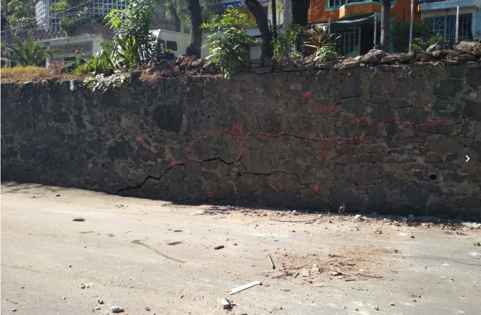
Fotografía 51. Talud de terraza en carretera México – Tulyehualco
