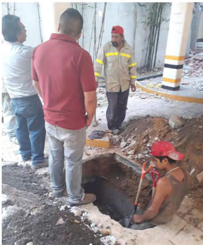
ESTUDIOS DE MECÁNICA DE SUELOS FOTO: RODOLFO TORRES
