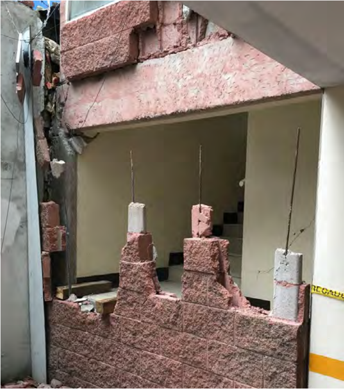
MURO DE ESCALERAS FOTO: RODOLFO TORRES
