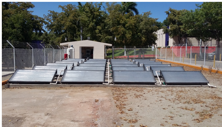
Figura 7.12: Obra concluida en Sinaloa
