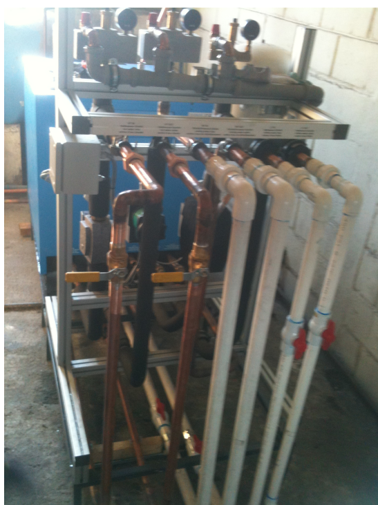
Figura C.6: Conexión mecánica del chiller
