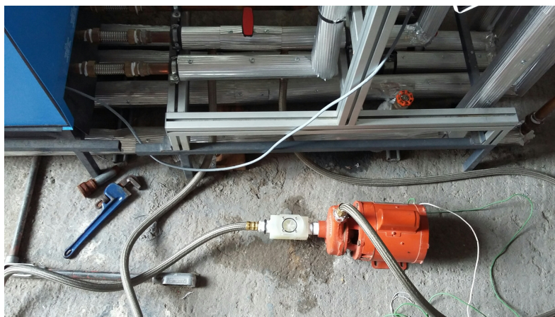
Figura C.14: Reparación de fallas electromecánicas
