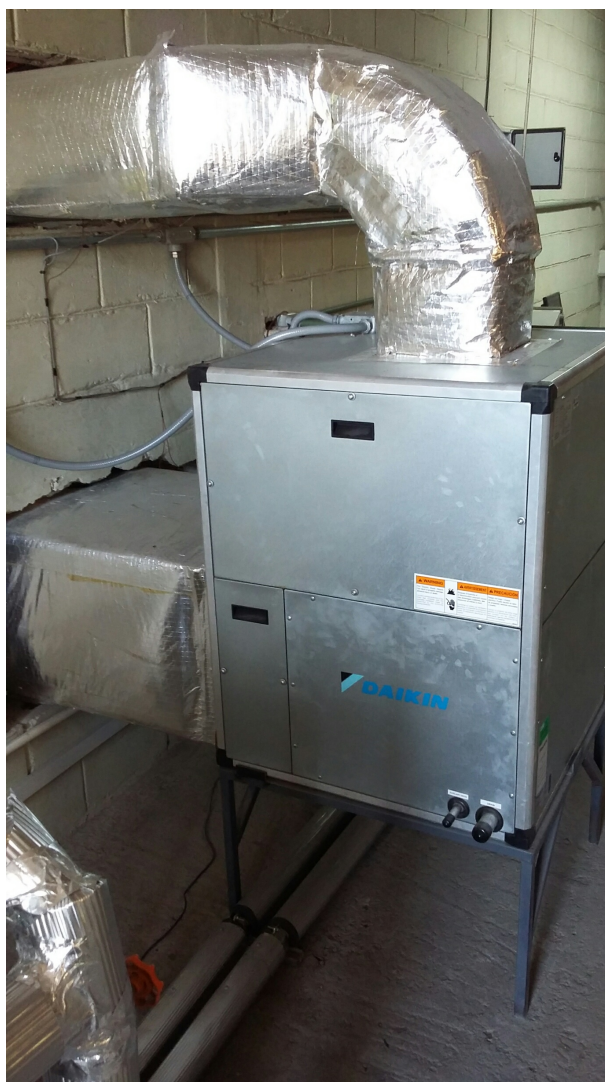
Figura C.10: Canalización de aire y conexión de UMA a la red de ductos
