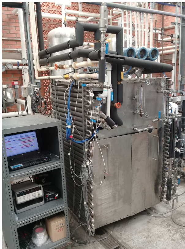
Figura 4.19: Equipo totalmente terminado y acoplado a servicios auxiliares, así como al sistema de adquisición de datos.
