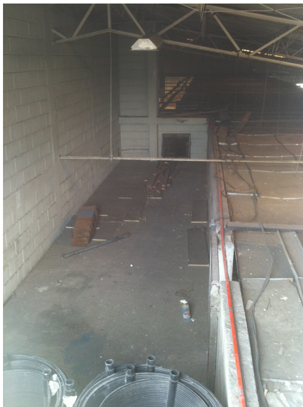
Figura C.2: Obra gris (Futuro cuarto de máquinas)
