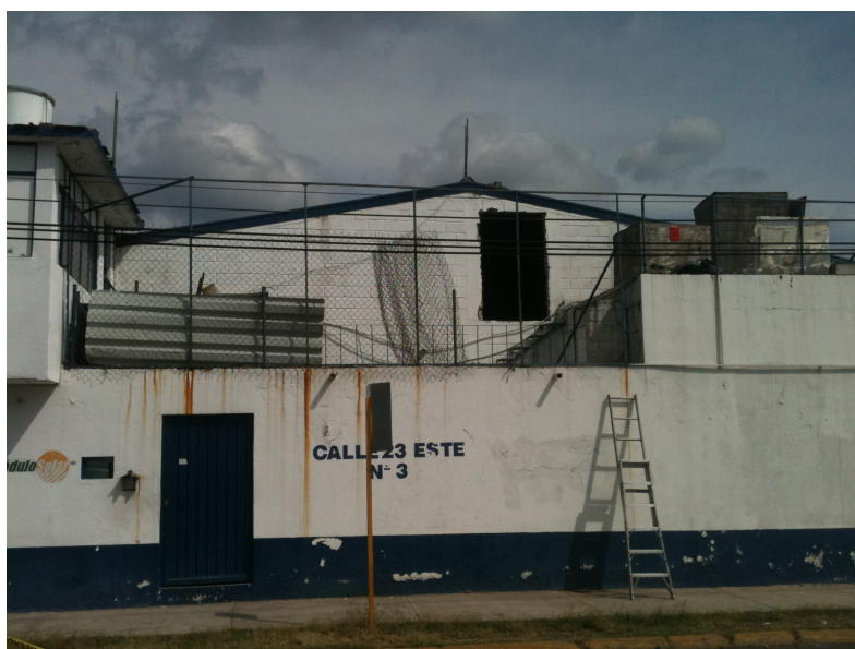
Figura C.4: Obra gris (Futuro cuarto de máquinas)
