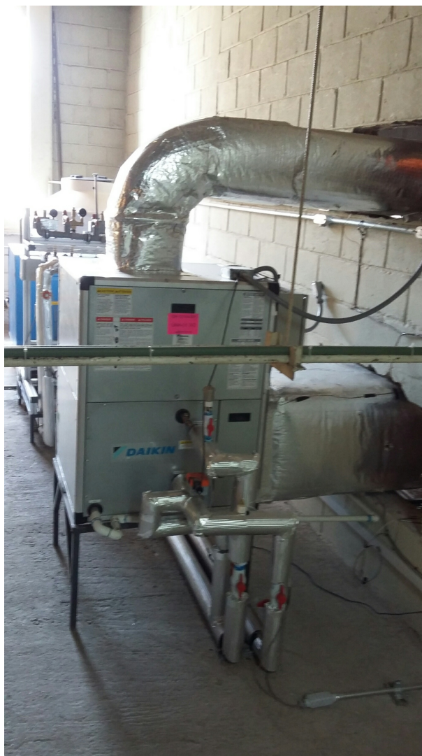
Figura C.11: Canalización de aire y conexión de UMA a la red de ductos
