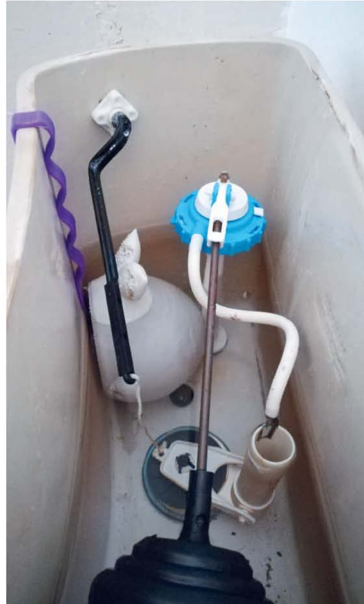
Figura 65. Foto del prototipo volumétrico dentro del tanque
