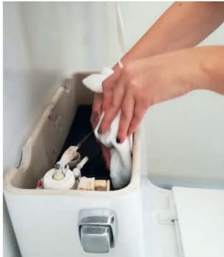
4. Colocar el cuerpo bajo el brazo de la palanca de descarga.
