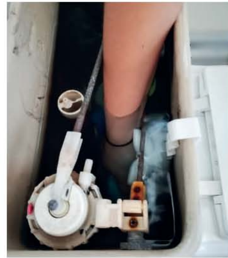
6. Esperar a que el cuerpo se llene de agua (recuperando su forma), y expulse el colorante azul en el tanque.
