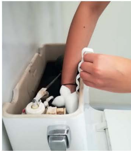
5. Asegurar el sujetador en la pared del tanque.
