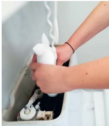
11. Extraer a LBA del tanque para su limpieza.
