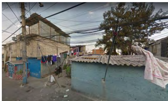
V4. Vista acceso desde la calle Héroes de La Intervención
