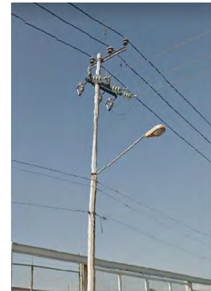
Imagen.- Poste de luz eléctrica ubicados en la Av. Bordo de Xochiaca utilizado igualmente para la red de teléfono.
