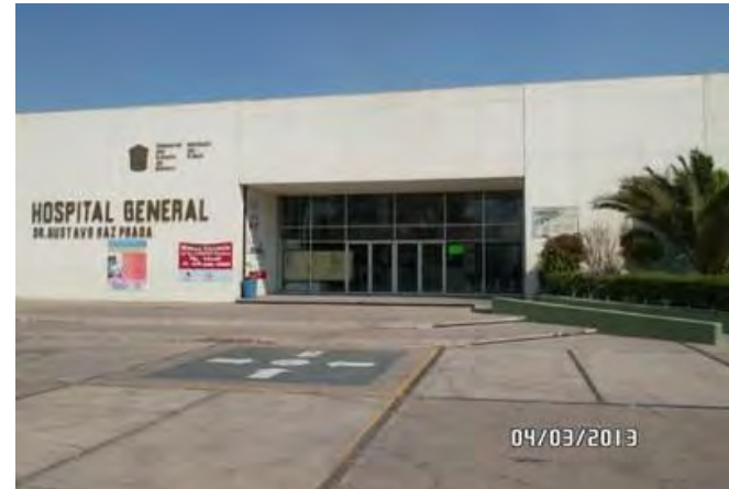
Figura 75 Hospital General Gustavo Baz Prada. Luce un tanto descuidado como los edificios del entorno
