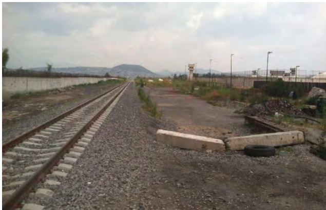
Figura 66 (Izquierda) Predio, (Derecha) Cableado del palacio de justicia. Las vías del tren dividen el cementerio de la Av. Adolfo López Mateos, generando un acceso discreto al mismo
