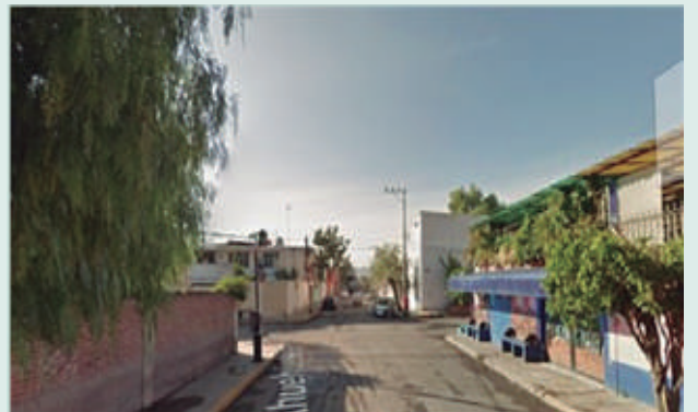
F4. VISTA DESDE CALLE AHUEHUETES A ESQUINA DE PREDIO.
