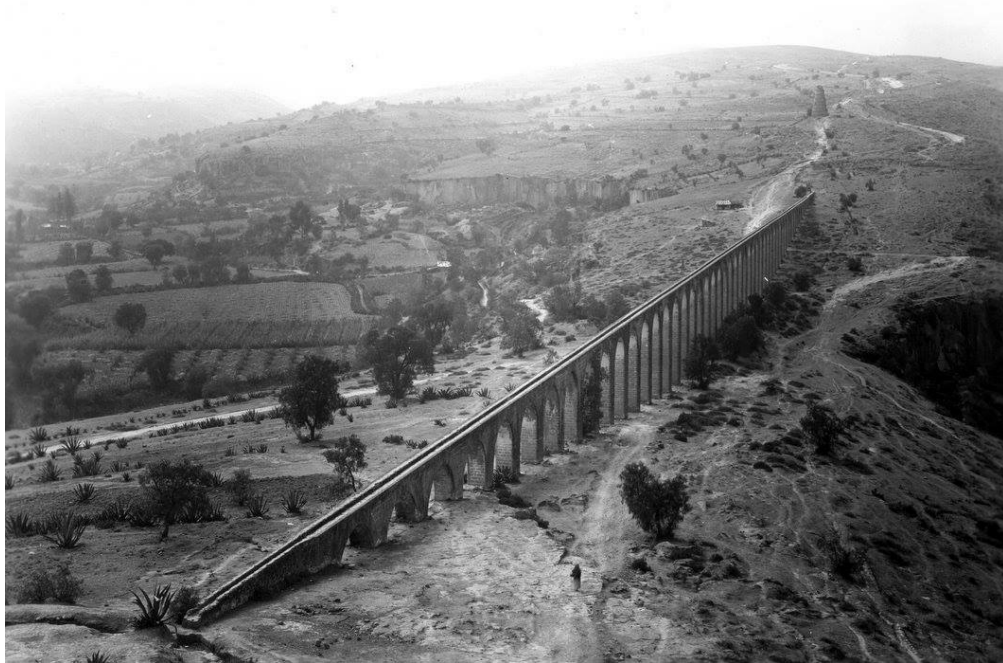
Ilustración 45. Acueducto de los Remedios construido entre 1616 y 1765, la imagen es de 1930. Fuente: Acervo Fototeca Nacional del INAH
