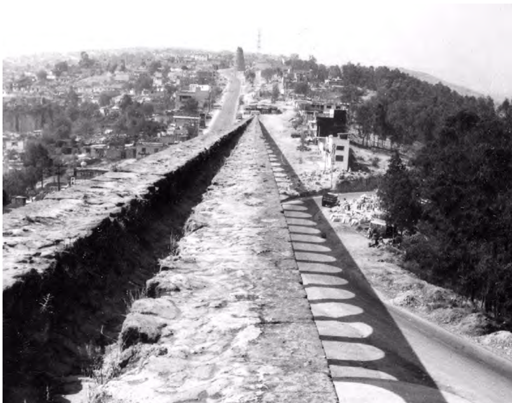
Ilustración 46. Vista del acueducto de los Remedios a inicios de 1970. Fuente: Col. Villasana-Torres/La Ciudad de México en el Tiempo.z
