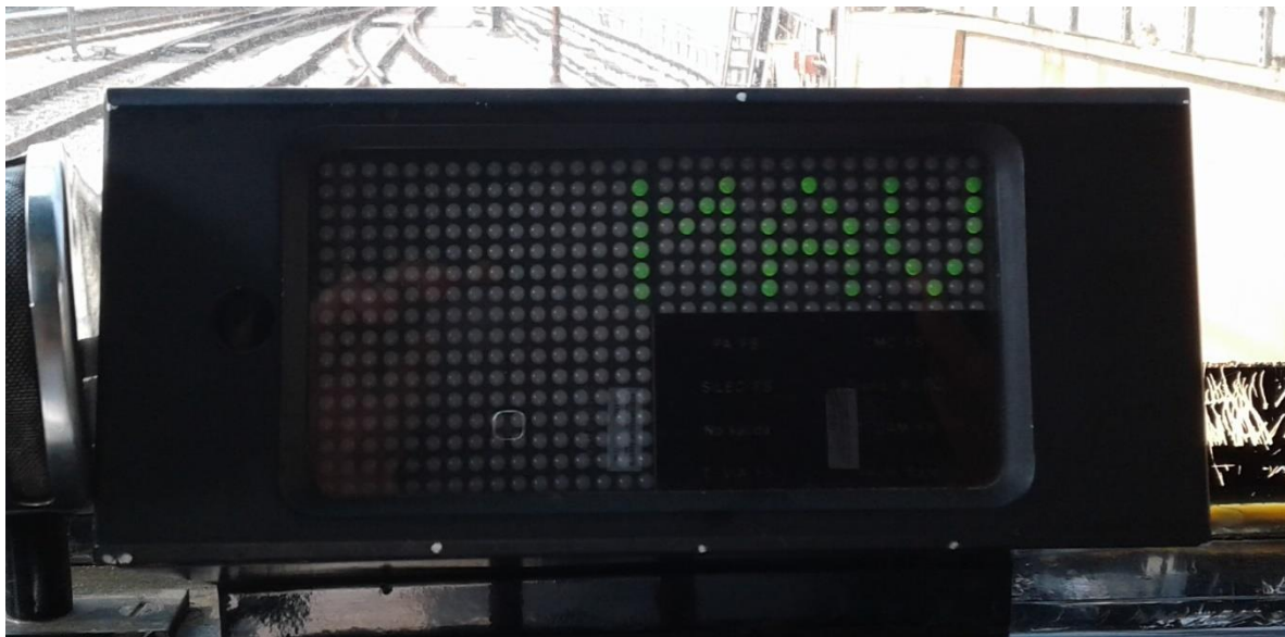
Fig. 1.27: AFF (señalización visual en la cabina VISUCAB).
