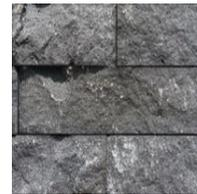
M-4 Cintillas de piedra marca Macere, color recinto negro, colocado con adhesivo para recubrimientos de alta absorción de humedad Cpega tradicional.
