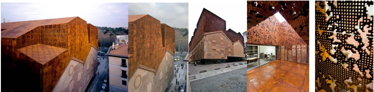
ILUSTRACIÓN 13 CAIXA FÓRUM (HERZOG & DE MEURON)
