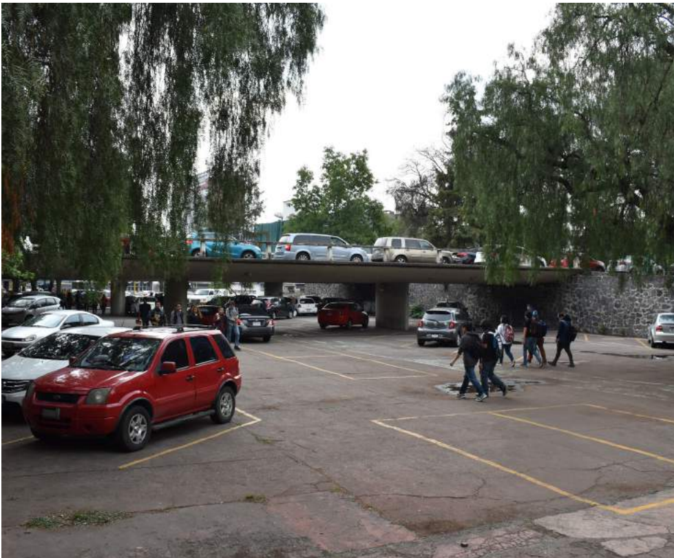
5.6 Bajopunte de Ingeniería ocupado por automóviles, 2018. Eridani Reyes.
