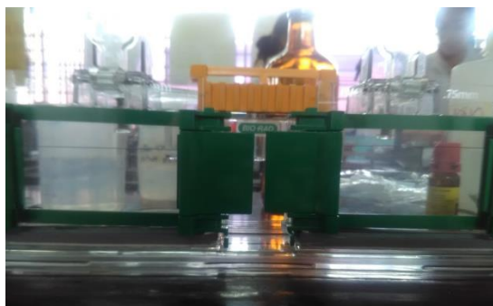
Figura 22. Instalación de placas de vidrio.
