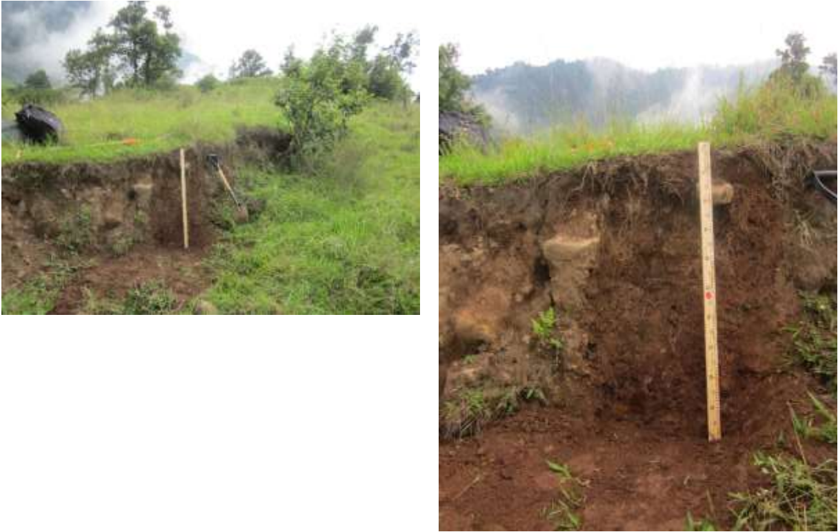
Figura 54. Perfil expuesto EV-7 entre el escarpe y el flanco derecho del deslizamiento. X: 739096, Y: 2182973, Z: 1440 m
