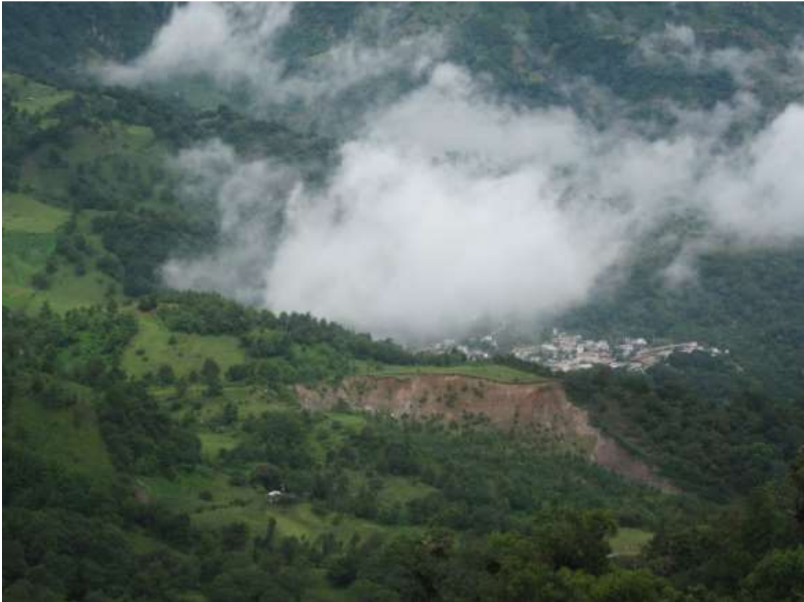
Figura 1. Comunidades de El Escalanar y El Capulín en el flanco izquierdo del deslizamiento
