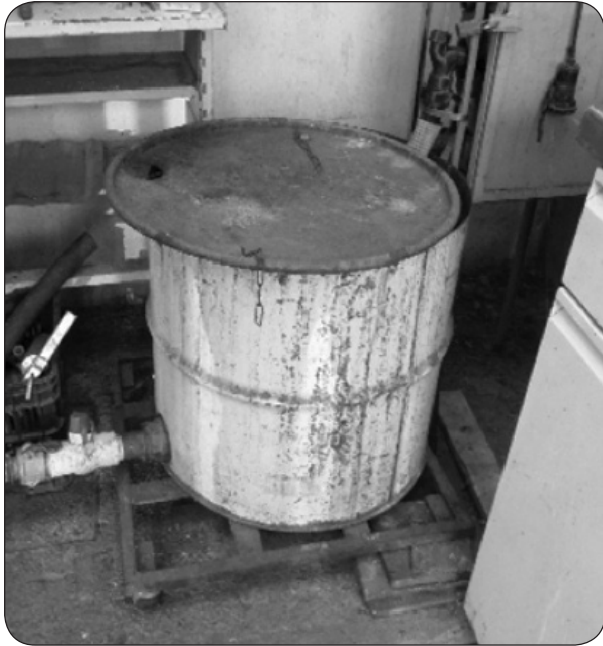
Figura 2.32 Primer tanque receptor de sustrato que muestra los signos de corrosión
