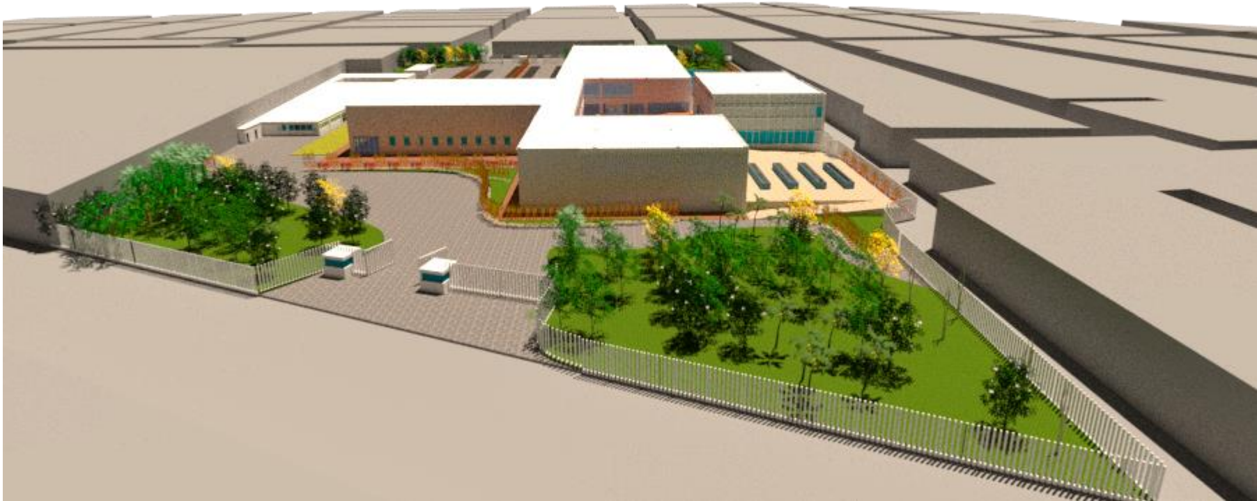
Acceso vehicular sur hacia urgencias y servicios generales
