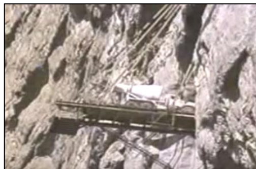
Figura IV.15 Movilización de un silobús en la plataforma a 220m de altura en las instalaciones del P.H. Zimapán.
