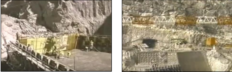
Figura IV.22 Fotos de la construcción de la cortina del P.H. Zimapán.
