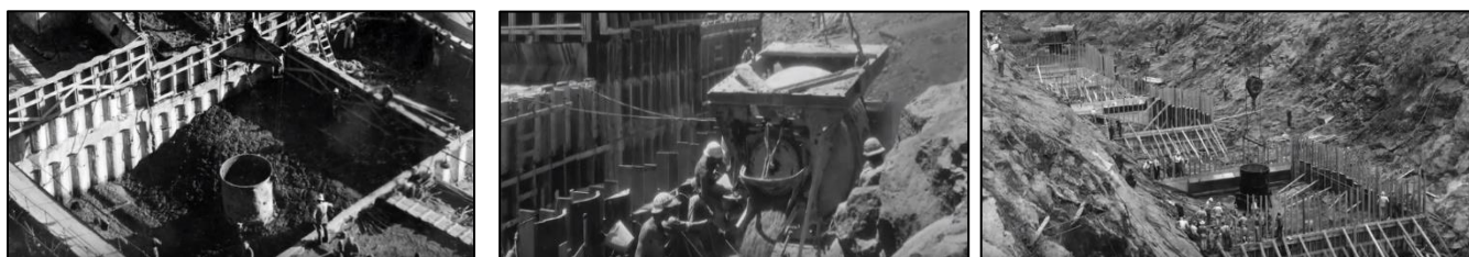
Figura IV.21 Colocación del concreto por medio de cubetas en la cortina.
