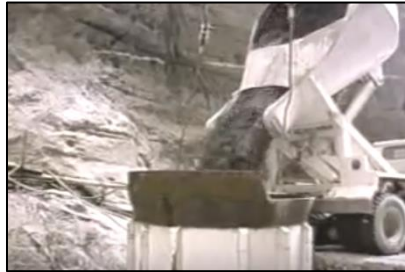
Figura IV.13 Descarga del concreto desde los silobuses a la cubeta en el P.H. Zimapán.
