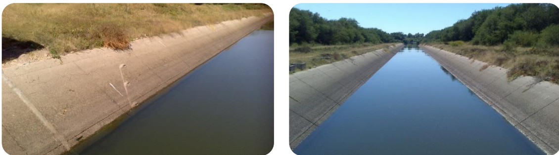
figura 3. Canal Principal de la presa Josefa Ortiz de Domínguez, en Sinaloa.
