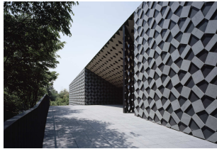
Centro comunitario Kanayama. Kengo Kuma.
