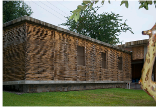
Edificio comunitario de muros de bahareque. del Colectivo bma
