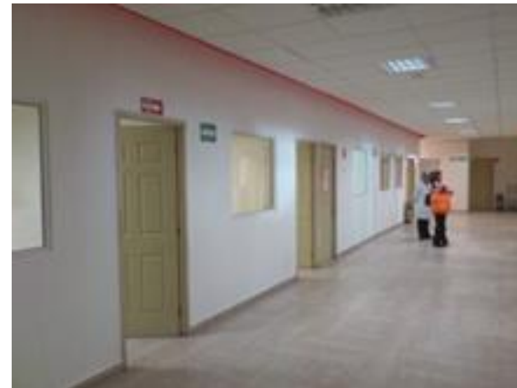
Área de consultorios
