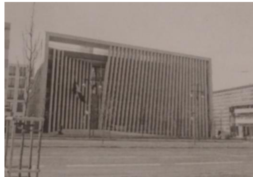
Embajada de México en Alemania Fachada Principal Foto: J. Francisco Serrano Arquitectos
