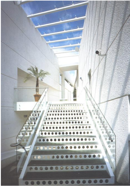
Embajada de México en Guatemala Escalera de Acceso Foto: Pedro Hiriart
