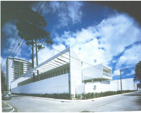
Embajada de México en Guatemala Fachada Foto: Pedro Hiriart
