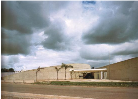
Embajada de México en Belice Fachada Principal
