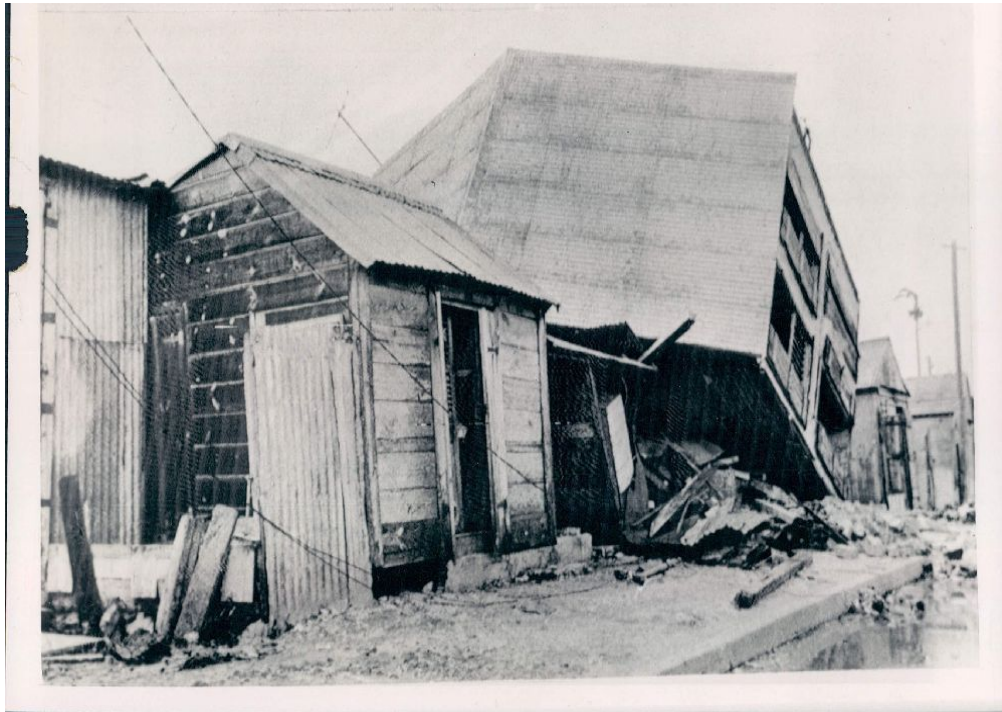
Figura. A-13.- Casa derrumbada en Isla Guadalupe (29 de sep 1966), cientos de casas fueron destruidas por los fuertes vientos, 23 personas perdieron la vida así como 10,000 personas se quedaron sin hogar al paso del huracán Inez 1966 (UPI TELEPHOTO)
