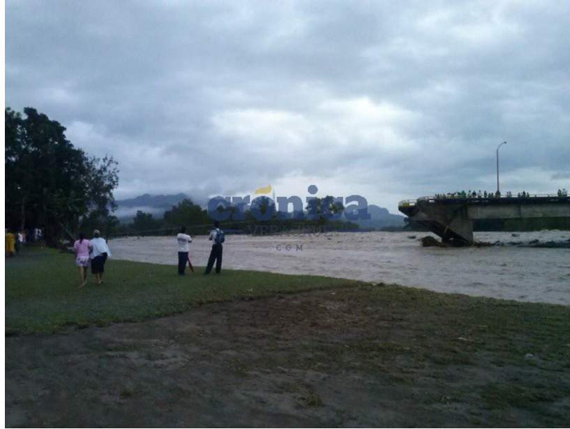
Figura. A-39.- Puente derrumbado en el estado de Veracruz a causa de las lluvias torrenciales (Cronica,1995).
