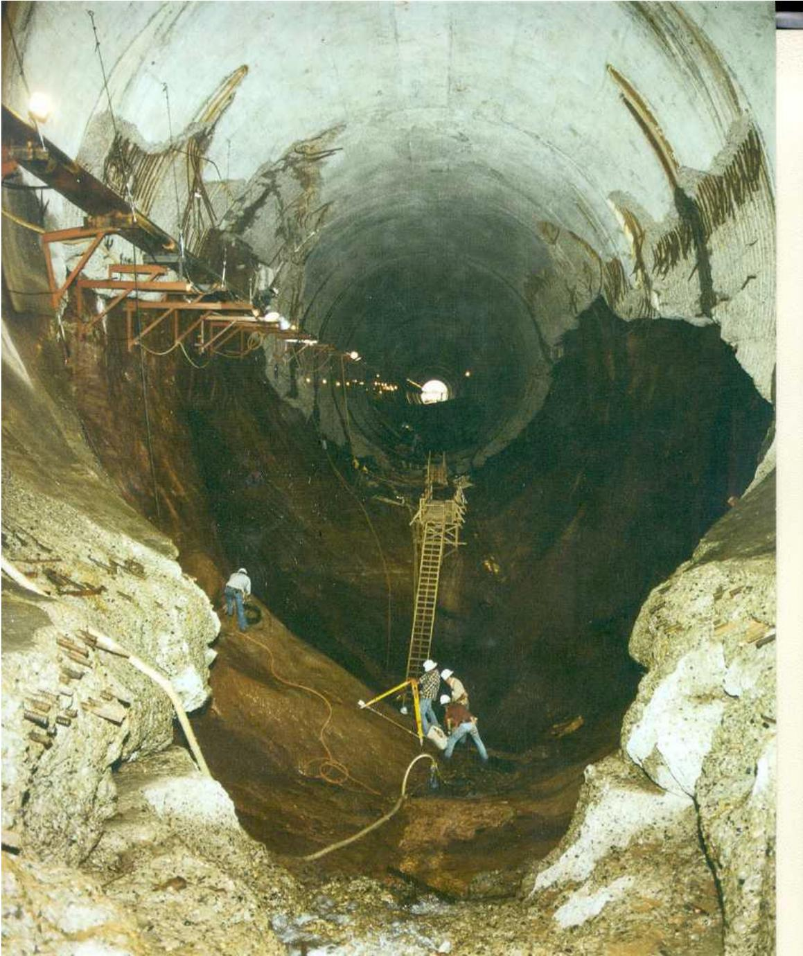
Figura I-6 Presa Glen Canyon. Túnel izquierdo del vertedor Sept. 1983. El “gran agujero” en el vertedor tenía 11 metros de profundidad (Falvey H. T., 1990).
