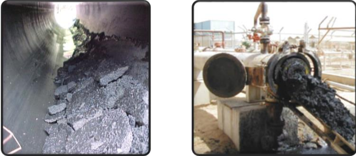
Figura 13. Eliminación de depósitos, arcilla, arena, entre otros desechos de pared interna de las tuberías
