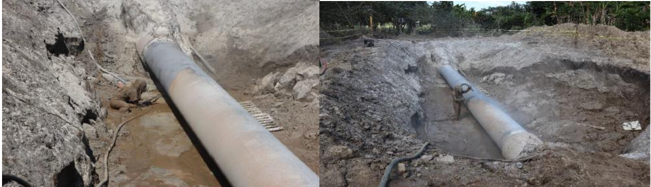
Fotografías 6,7. Limpieza de la superficie externa con chorro de arena.
