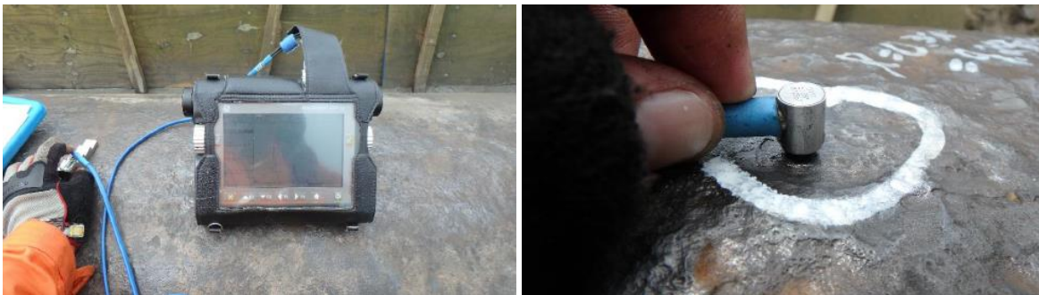
Fotografía 4,5. Ajuste en sitio del equipo de ultrasonido y medición del área de mayor profundidad en la anomalía 2
