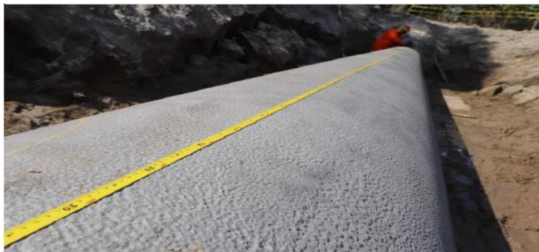
Fotografía8. Medición de la longitud de carrete y ubicación de referencias
