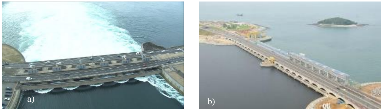
Figura 2.9 a) Central de La Rance en Francia, b) Central Sihwa en Corea del Sur
