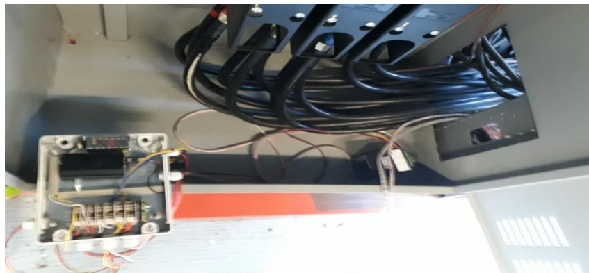
Figura 4.3 Instalación del concentrador para el ANR96 LAN
