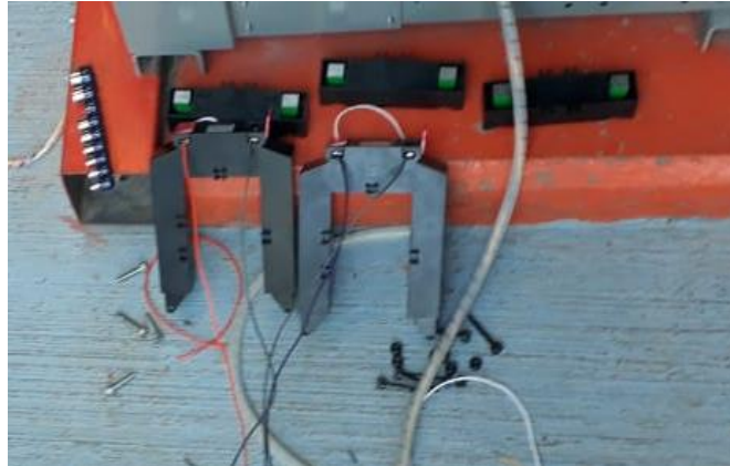
Figura 4.2 Instalación de TC's
