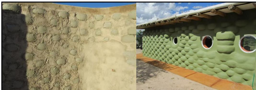
Imagen 40: Construcción de vivienda con neumáticos Fuente: <http://www.traslasierra.com/Casa-Construida-con-Neumaticos>
