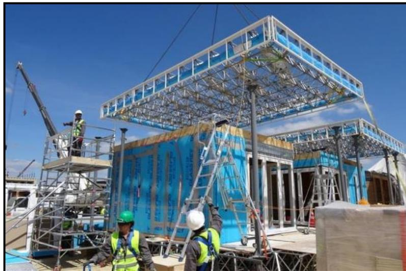
Imagen 50: Sistema Tridilosa UNAM
