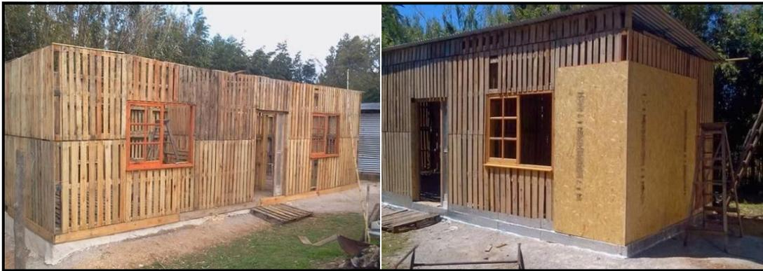
Imagen 45: Construcción en proceso con palets
