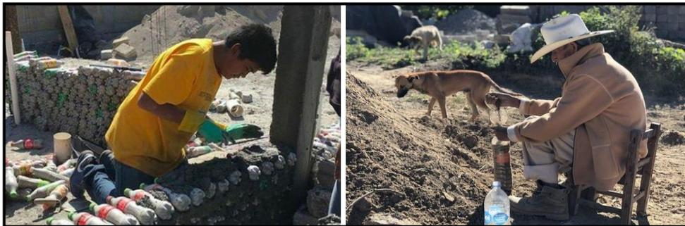
Imagen 37: Construcción de vivienda con PET relleno de tierra.
