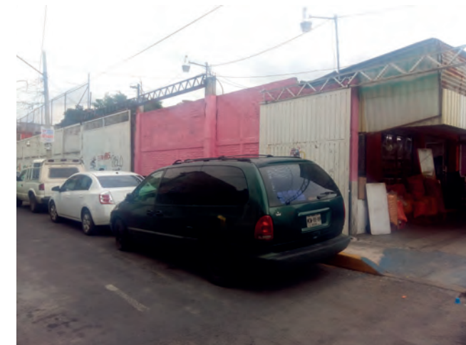
4. Fachada Lateral (Acceso y zona de carga/descarga)
