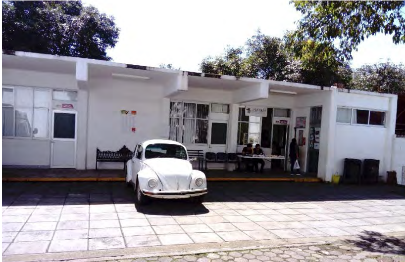
Vista del edificio administrativo donado por el DIF para servicio del INAPAM.
