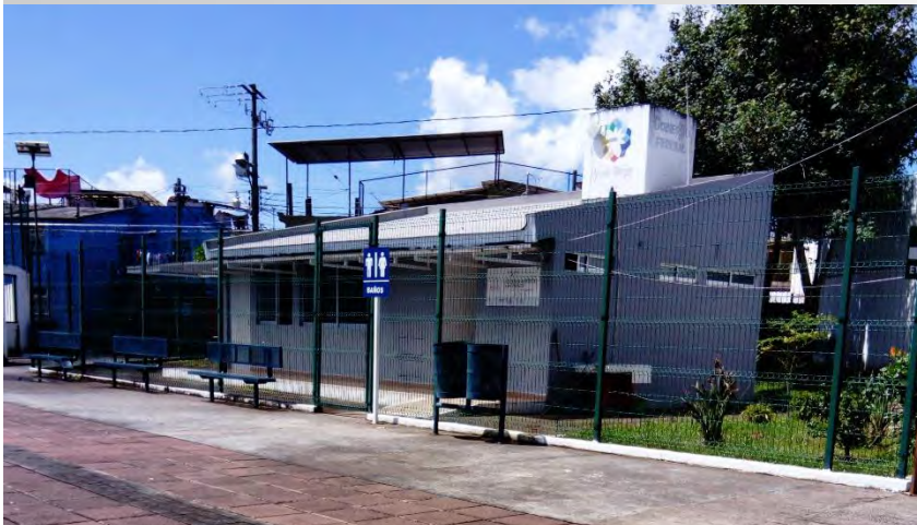
Vista de sanitarios y salón de usos múltiples.
