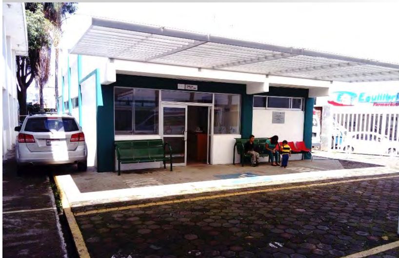
Vista del nuevo edificio de rehabilitación física con tanque de hidroterapia.
