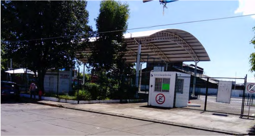
Vista exterior del CEDECO vallado y caseta de vigilancia.
