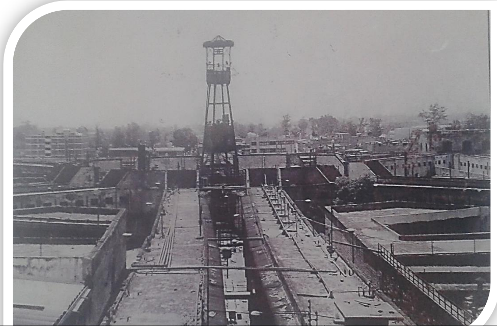
Torre central de acero desde donde se vigilaban las 7 crujiás, las cuales eran de diversas longitudes. Fuente: Libro Los personajes del cautiverio. Prisiones, prisioneros y custodios.
