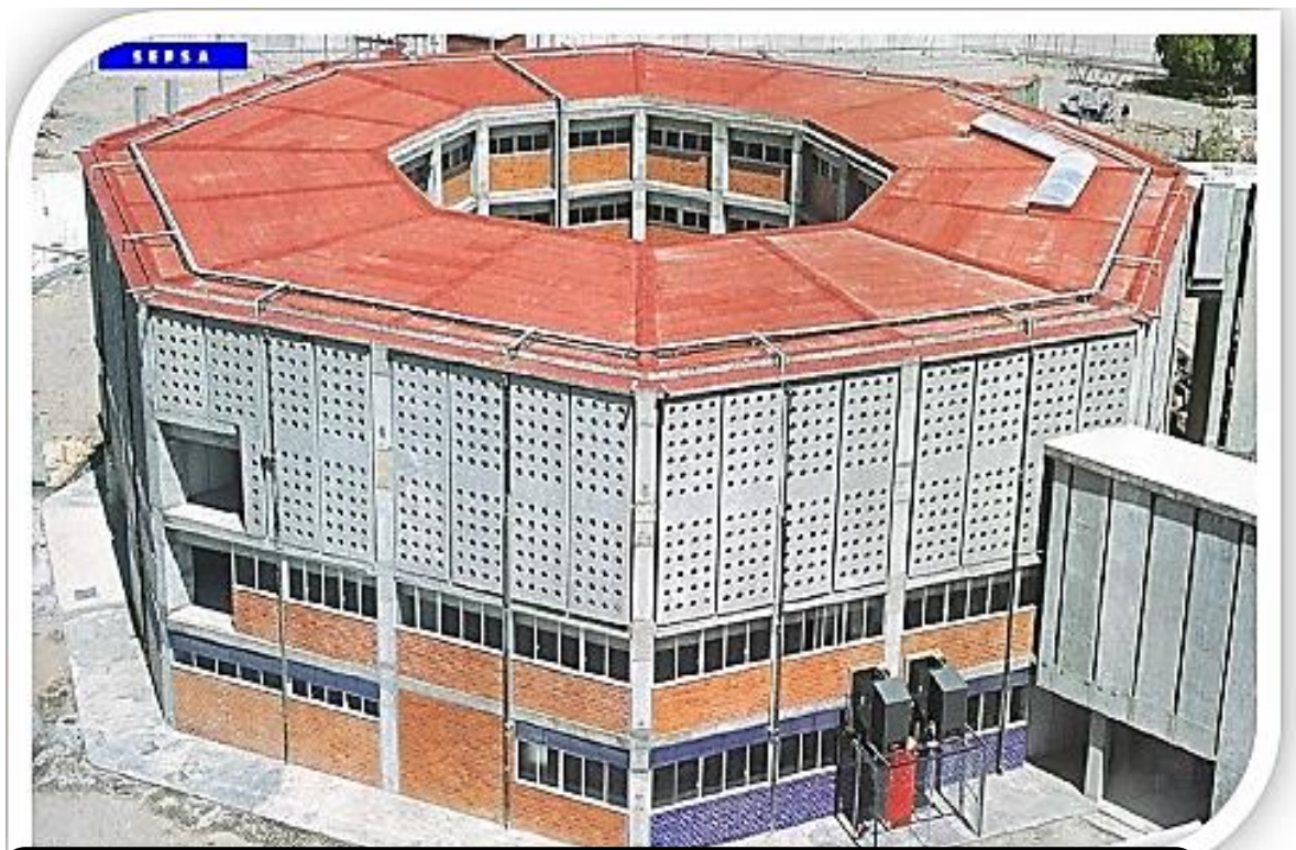
El interior de Santa Martha. Fuente: Constructora Sepsa , www.sepsacv.com.mx/proyectos .
