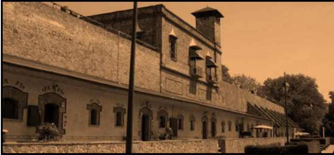
Imagen 2: La Trinidad actualmente Centro Vacacional del IMSS.
