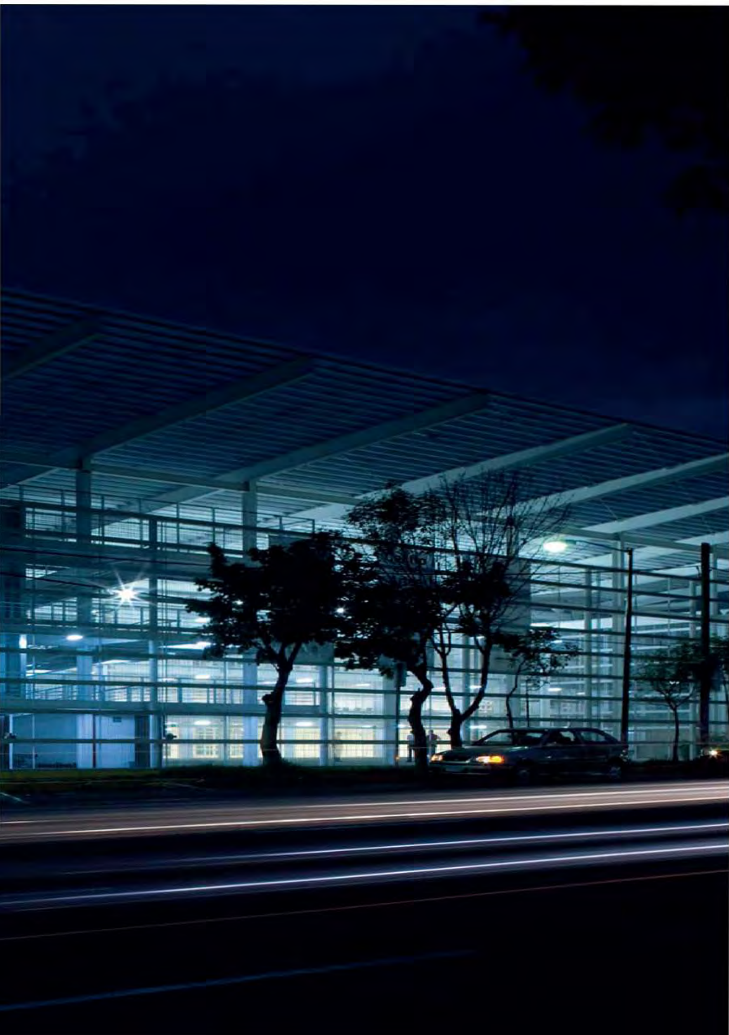
Imagen 51: Vista de la fachada del Centro de las Artes Santa Úrsula. Fuente: http://www.raulpena-architects.com/en/work/centro-de-artes-santa-ursula.html
