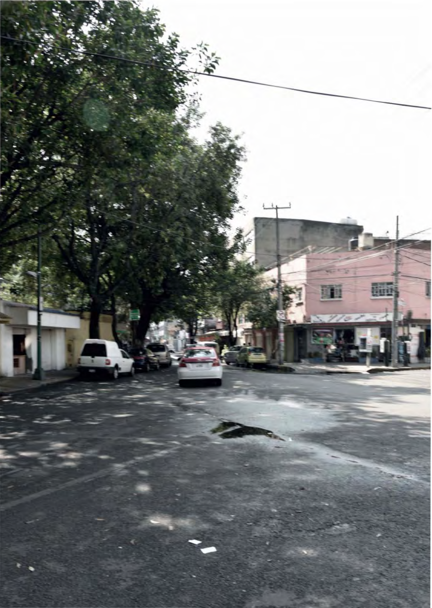
Imagen 11: Vista del predio hacia la esquina de Eleuterio Méndez y Calz. San Simón. Fuente: fotografía tomada en sitio.
