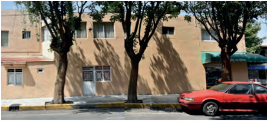
Imagen 17: Larguillo sobre la Calzada San Simón lado sur. Se observa el edificio en donde te encuentra la fundación Dondé (5 niveles), vivienda unifamiliar (1 nivel) y vivienda con comercio en planta baja (2 niveles). Fuente: fotografías tomadas en sitio.
