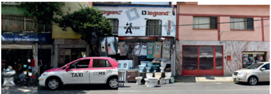
Imagen 19: Larguillo sobre la calle de Eleuterio Méndez lado sur. Se observa de izquierda a derecha; vivienda con comercio en planta baja (2 niveles), edificio de vivienda (6 niveles), vivienda unifamiliar (2 niveles), vivienda con comercio (3 niveles), comercio de plomería (2 niveles) y vivienda con comercio (2 niveles) . Fuente: fotografías tomadas en sitio.
