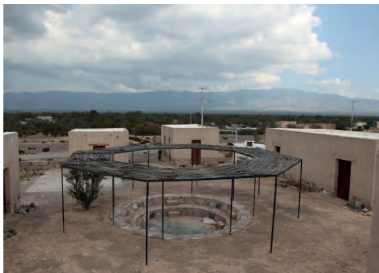
Imagen 49: Vista del centro de Diálogos. Fuente: Taller de operaciones ambientales.
