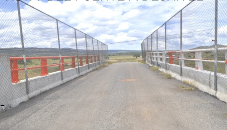
VISTA DEL PUENTE A DESNIVEL
