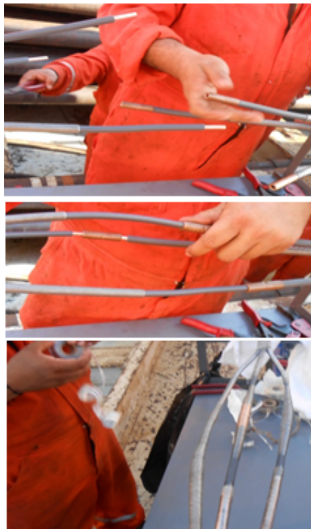
Figura 4.3: Proceso de empalme del cable de potencia.
