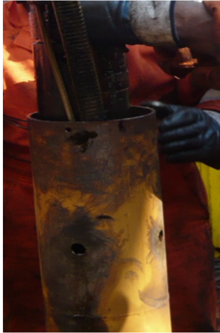
Figura 3.3: Instalación de camisa de enfriamiento.
