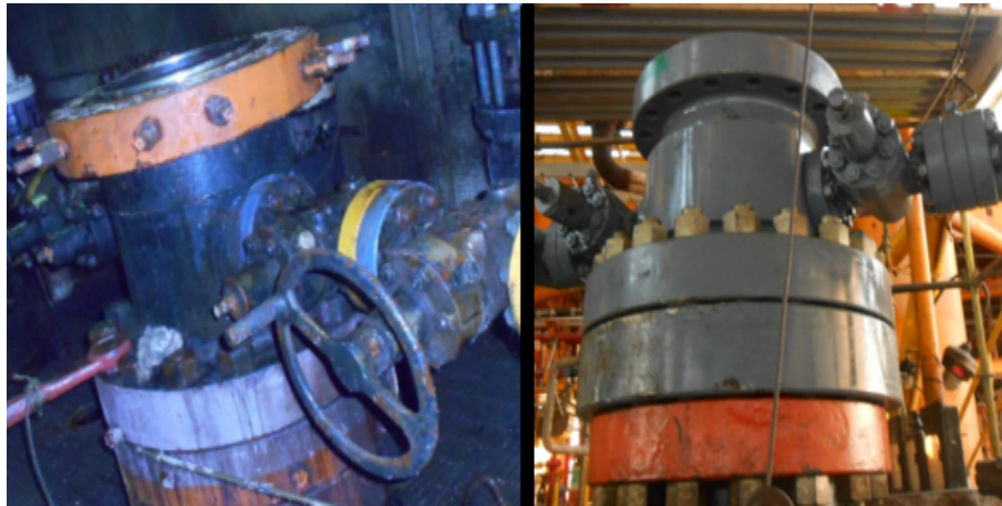
Figura 3.5: Sustitución de cabezales de producción.
