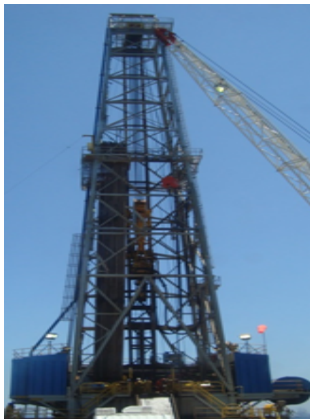
Figura 4.6: Torre de perforación.
