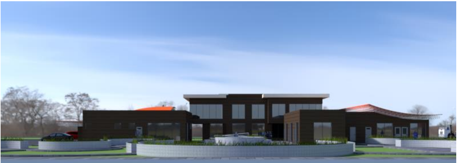
Fachada sur del área administrativa y servicios
