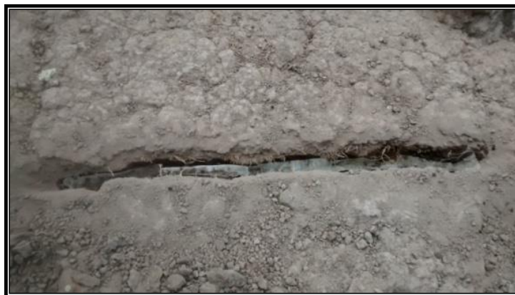
Figura 10. Implementación de zanjas.
