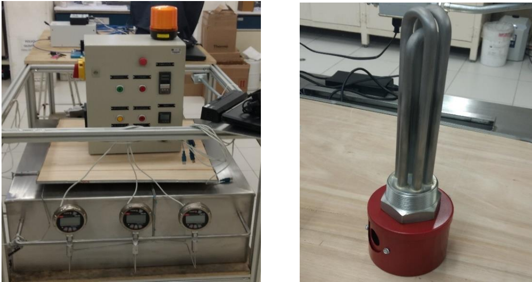
Figura 18 Tablero de control de temperatura (izquierda) y resistencia eléctrica (derecha).
