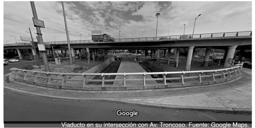
Viaducto en su intersección con Av. Troncoso. Fuente: Google Maps.
