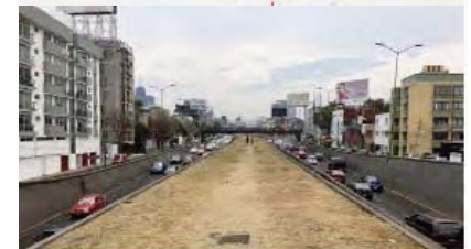
01. Viaducto Río de la Piedad
