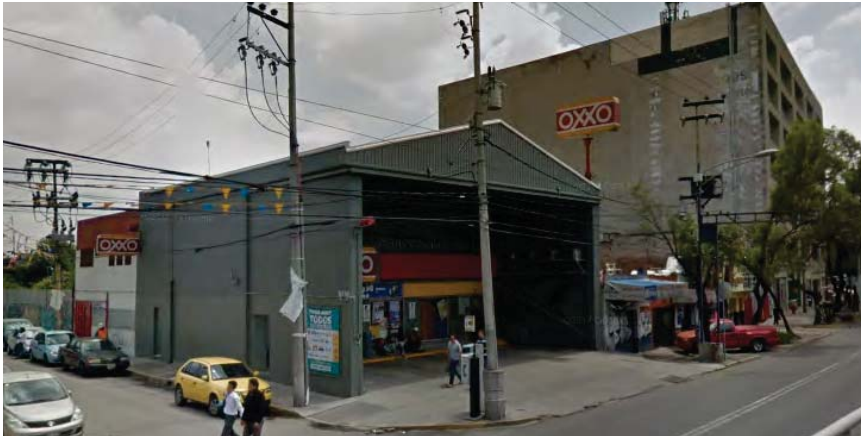
Sustitución de una antigua bodega por uso comercial ubicado sobre Av. Troncoso
