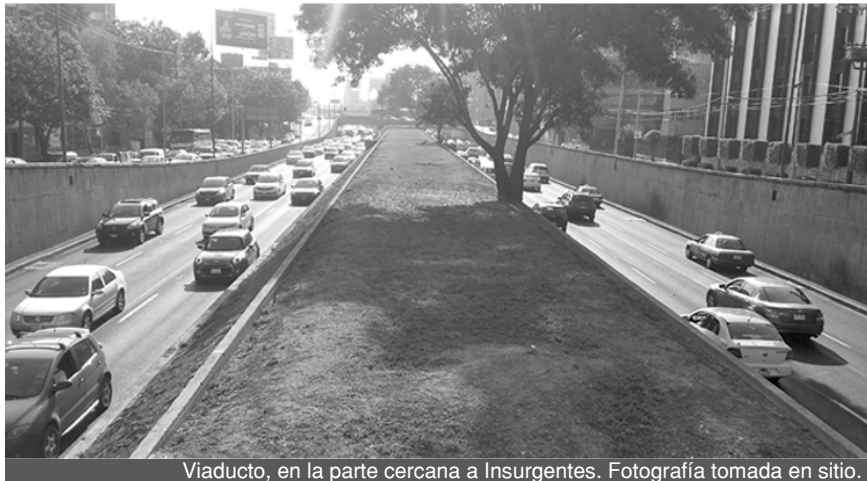
Viaducto, en la parte cercana a Insurgentes. Fotografía tomada en sitio.
