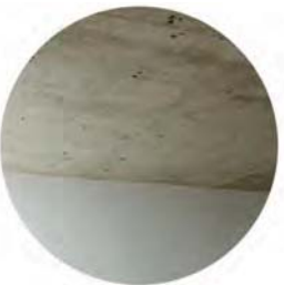
11.-Losa de concreto existente
