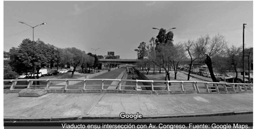
Viaducto en su intersección con Av. Congreso. Fuente: Google Maps.
