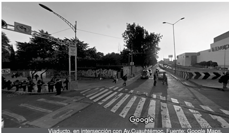
Viaducto, en intersección con Av. Cuauhtémoc. Fuente: Google Maps.
