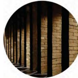
1.-Louvers de block hueco aparente
