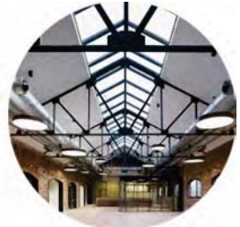
12.-Cubierta Multipanel existente
