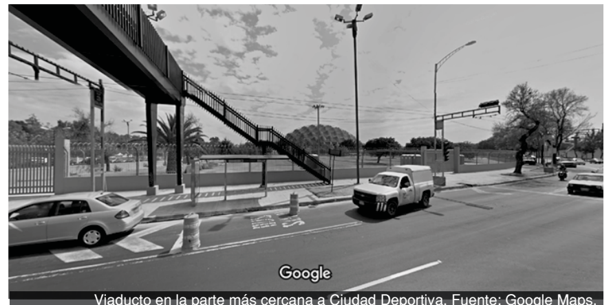
Viaducto en la parte más cercana a Ciudad Deportiva. Fuente: Google Maps.
