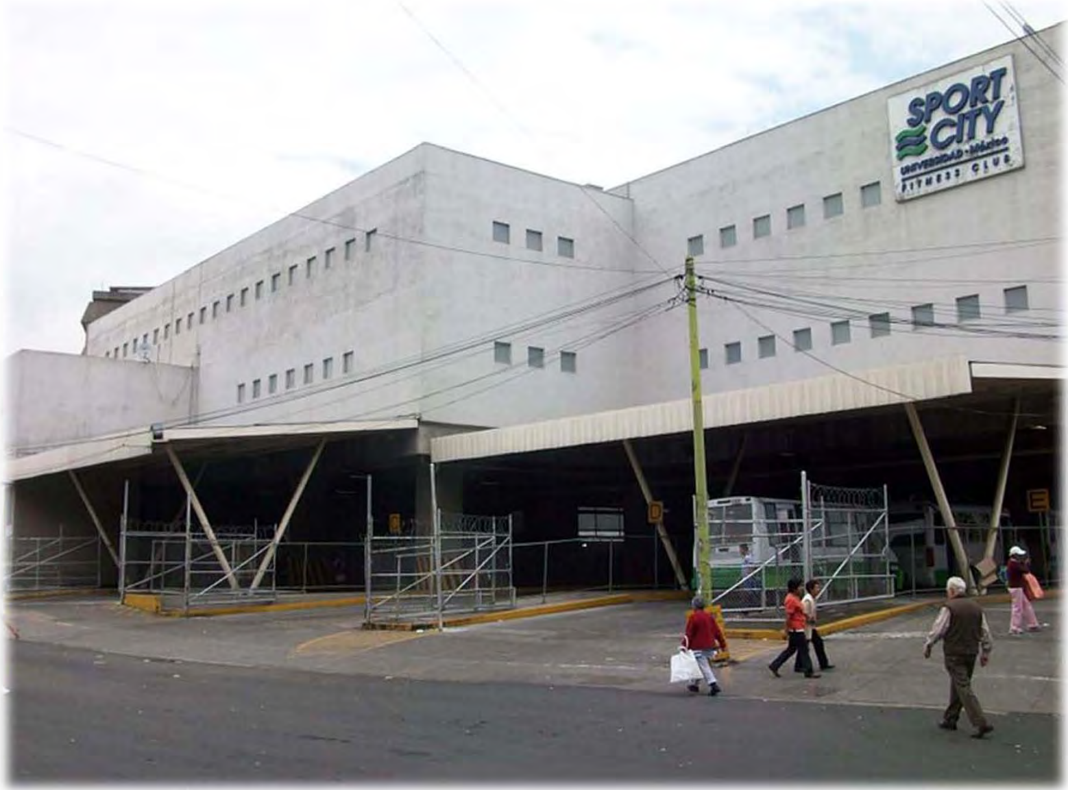
Imagen 9. CETRAM Metro Zapata.
