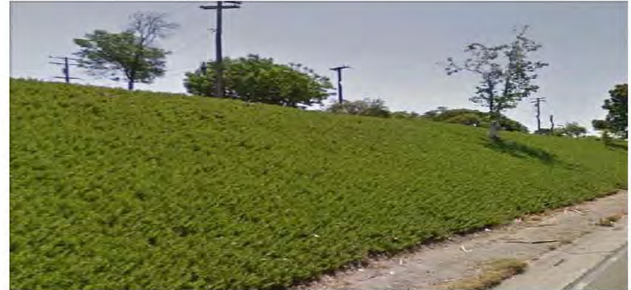
Imagen 15. Taludes verdes sobre vialidades.
