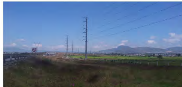
PREDIO 2- POSTES DE LUZ
